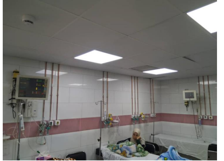
تنفيذ شبكة غازات طبية من ( انابيب نحاسية والمآخذ الطبية ووحدات رأس المريض و لوحات الفصل..)
