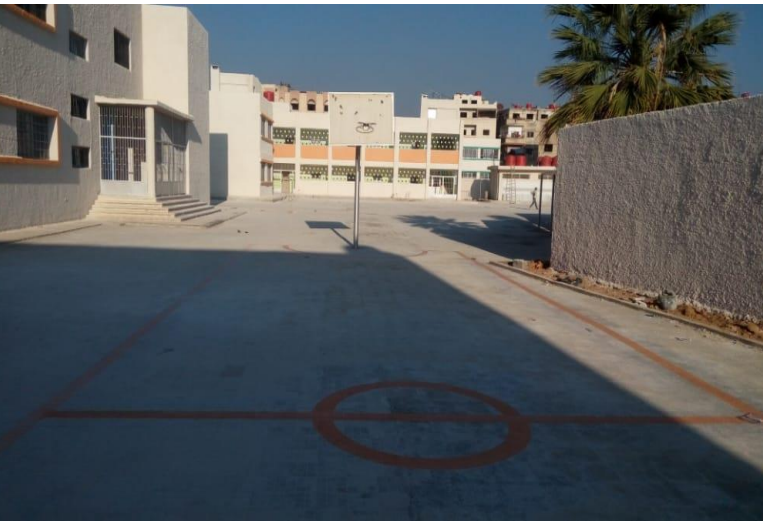
أعمال البلاط الخارجي و تخطيط الباحة
