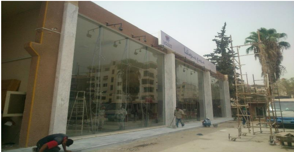
أعمال تنفيذ واجهة زجاج سيكوريت (مشروع اعادة تأهيل مول جرمانا) لصالح السورية للتجارة
