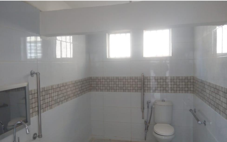
أعمال حمام ذوي الاحتياجات الخاصة
