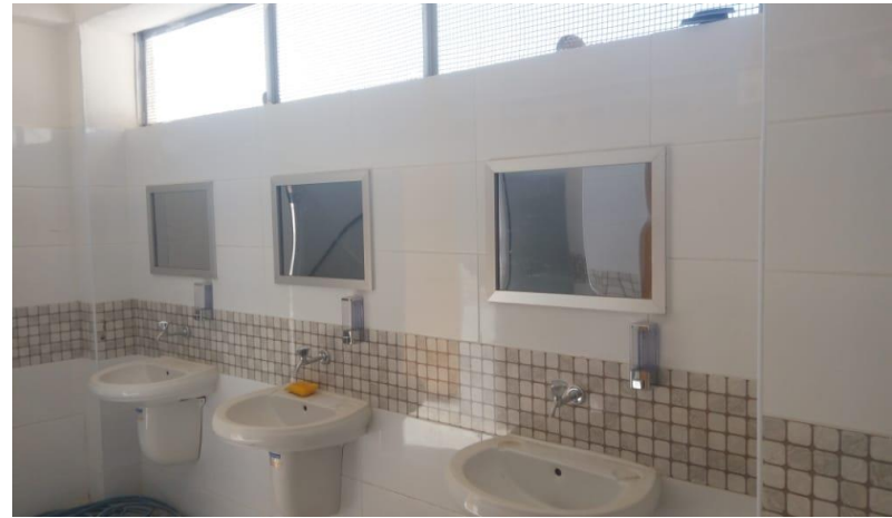
أعمال الحمامات ( مغاسل و حنفيات برم ايطالي)
