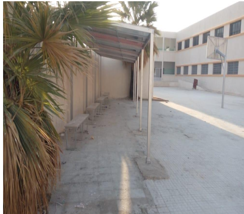
أعمال المظلة البولي كربونات
