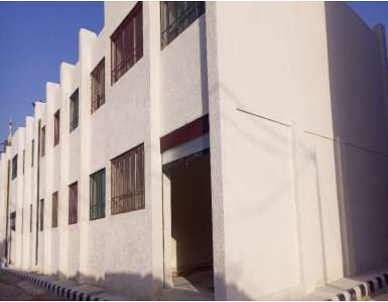
أعمال الرشة التيرولية للواجهات الخارجية
