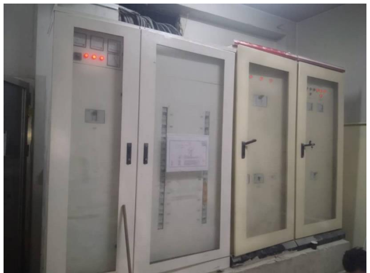
اللوحات الكهربائية (إعادة تأهيل مبنى العيادات في مستشفى الأطفال بدمشق) لصالح منظمة الصحة العالمية
