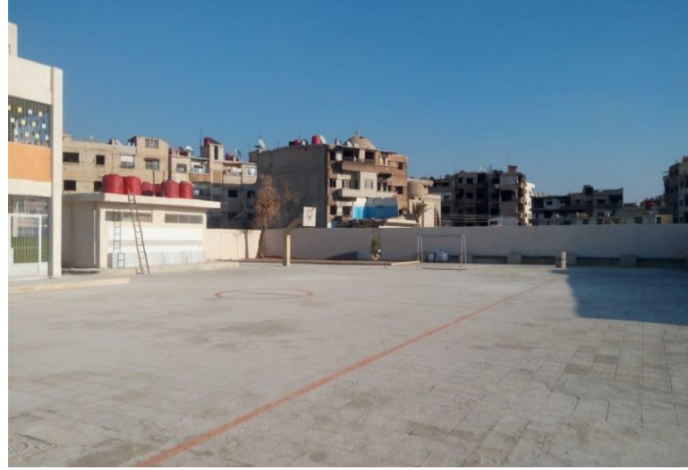
أعمال البلاط الخارجي و تخطيط الباحة
