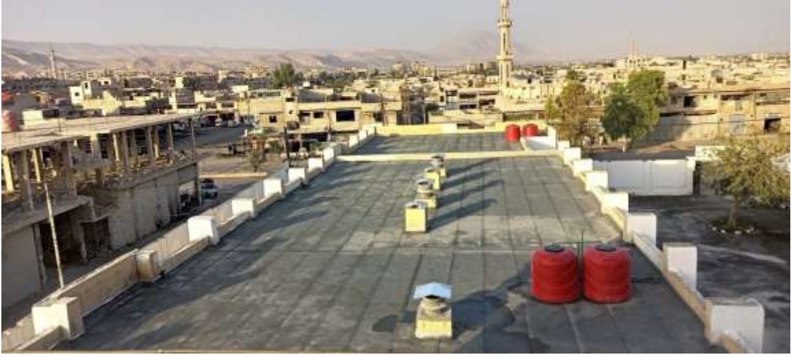
أعمال عزل السطح برولات البيتومين المبخص
