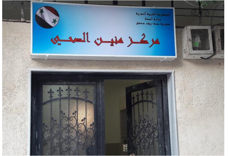
أعمال حديد مشغول (مشروع إعادة تأهيل مركز منين الصحي) لصالح منظمة ميدير
